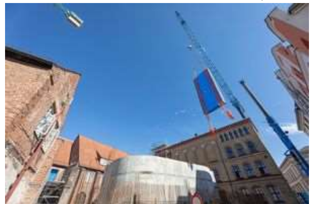
An einem Kran, der auch beim Bau von Windrädern genutzt wird, schwebten die Scheiben in den Rohbau des Großaquariums im MEERESMUSEUM. (Foto: Anke Neumeister/Deutsches Meeresmuseum)
