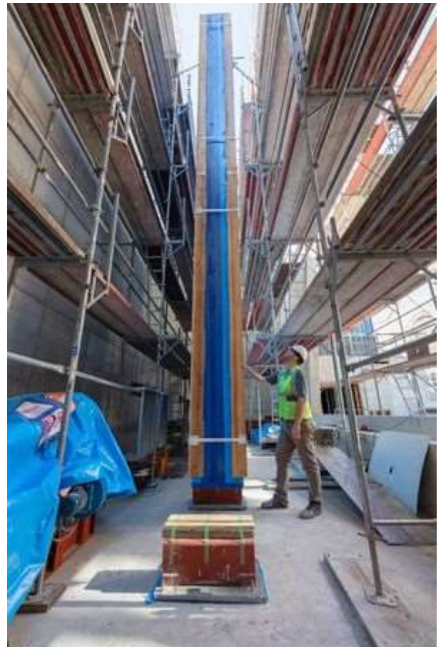
Die drei Scheibensegmente wurden im Rohbau zwischen zwei Gerüsten platziert. Hier werden sie nun über mehrere Wochen in einem aufwendigen Verfahren vertikal verklebt und anschließend in ihre Endposition in die Beckenlaibung gebracht. (Foto: Anke Neumeister/Deutsches Meeresmuseum)
