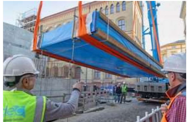
Mit zwei Kränen wurden in den engen Straßen von Stralsund die riesigen Scheiben in den Rohbau für das neue Großaquarium im MEERESMUSEUM gehoben. (Foto: Anke Neumeister/Deutsches Meeresmuseum)
